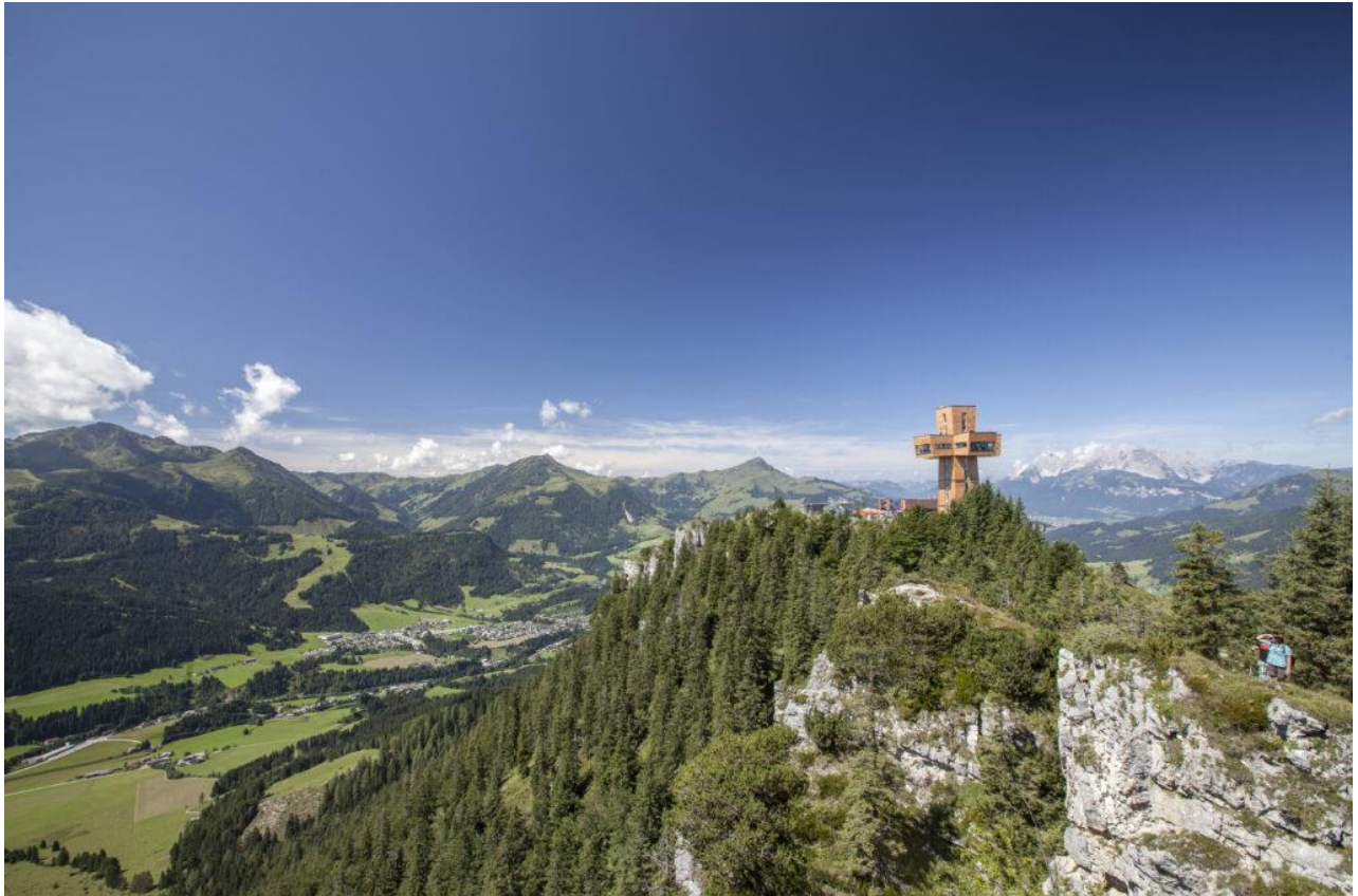
Das Jakobskreuz auf der Buchensteinwand (c) Bergbahn Pillersee
